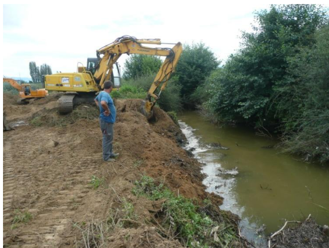
Чистење на канали за одводнување
